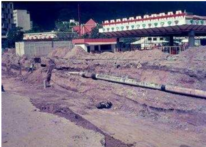
Fig. 15. Paleosuelo negruzco soterrado bajo deslaves torrenciales Q_{0a} de la Qda. Anauco (El Conde).
